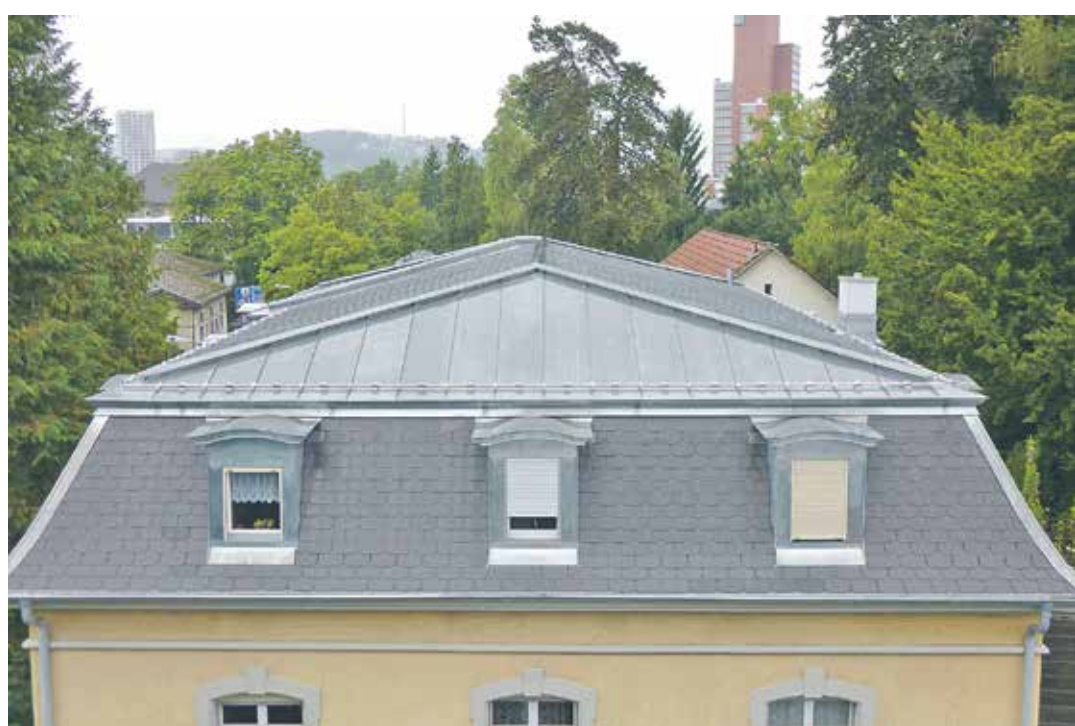
Eine Referenzarbeit auf einem Winterthurer Dach.
