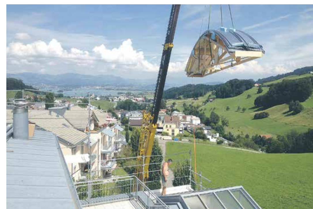
Nichts ist unmöglich: Die Montage von Blechscharen in Wollerau SZ.
