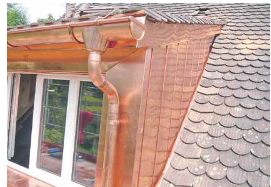
Sauberer Dachausbau aus Kupfer.
