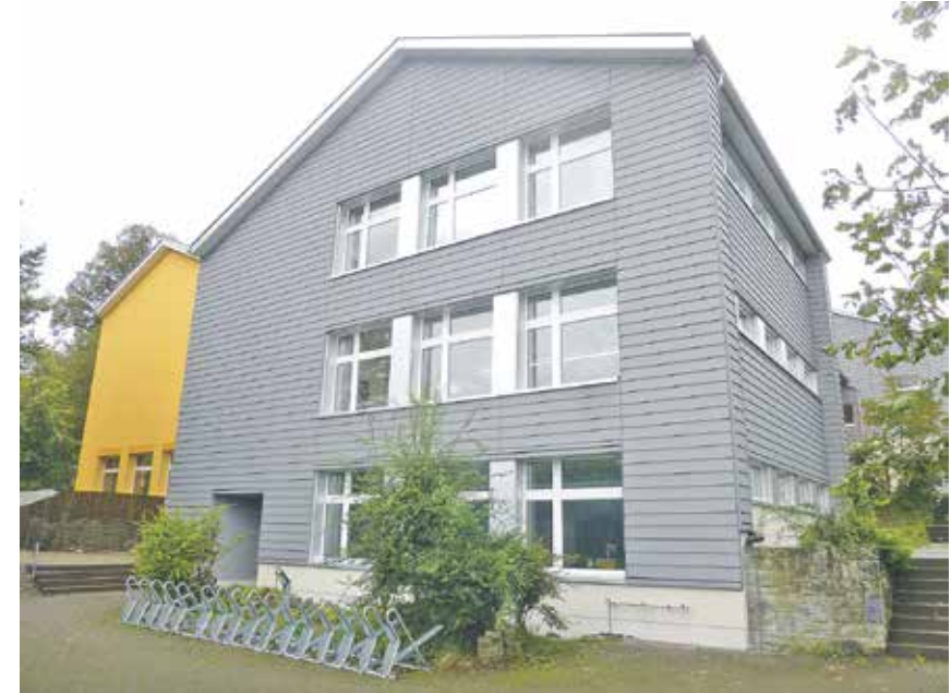
Massarbeit an der Fassade vom Sekundarschulhaus Elgg.
